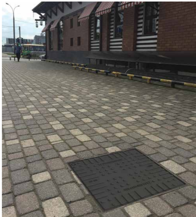
Установка люков на дождеприёмники Стандартпарк
